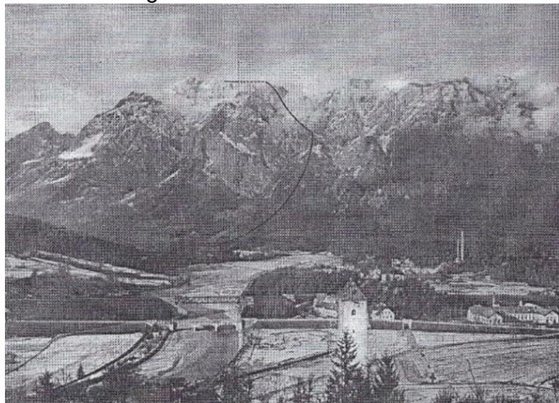
Abbildung 36: Projekt Drahtschwebbahn Dobratsch
